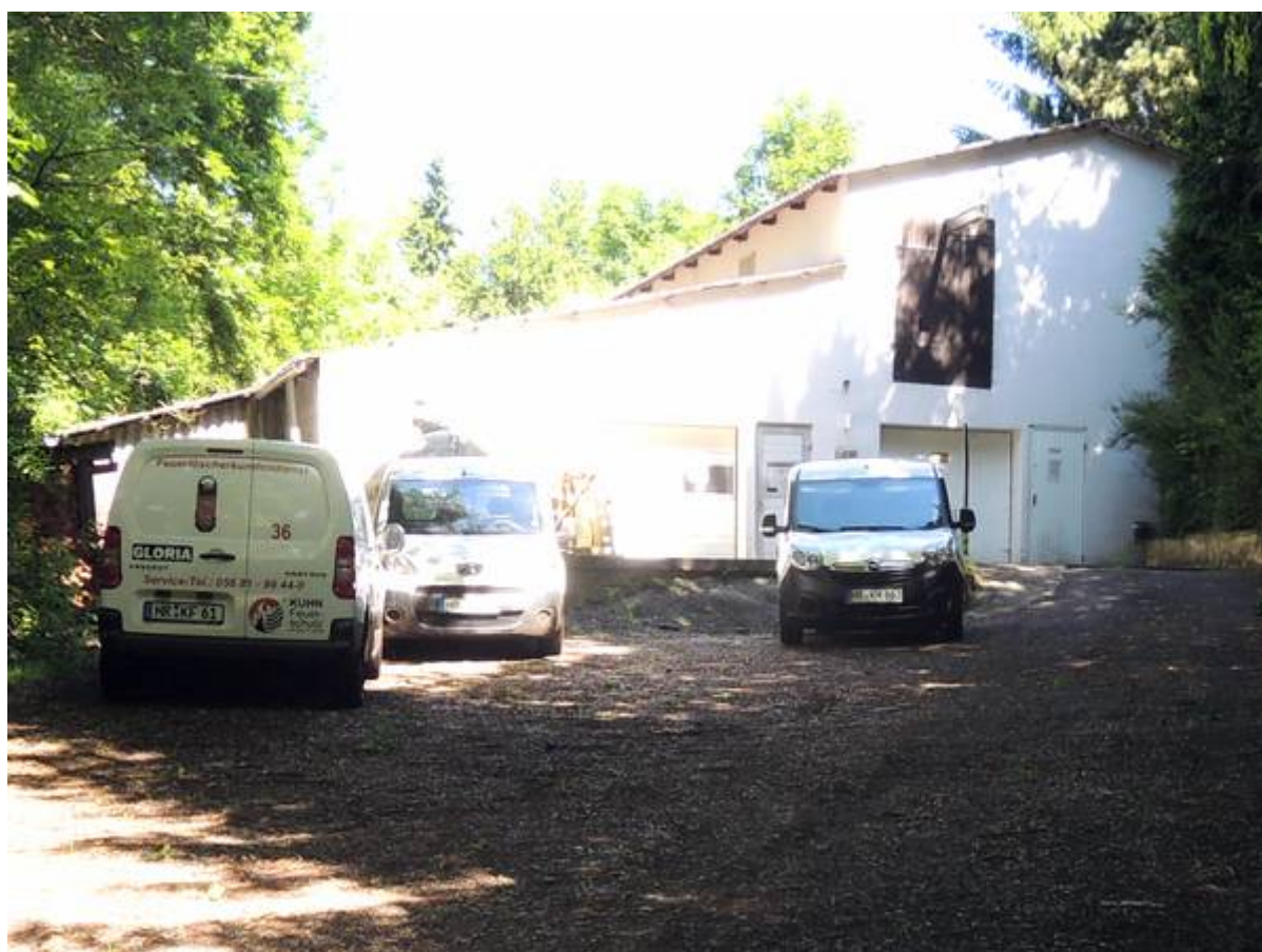
Abbildung 4: Hof und Gewerbegebäude
